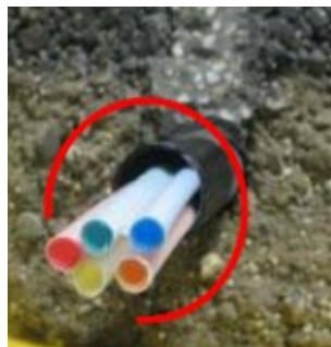
Figura 6 – Esempio di sottoequipaggiamento di un fodero
