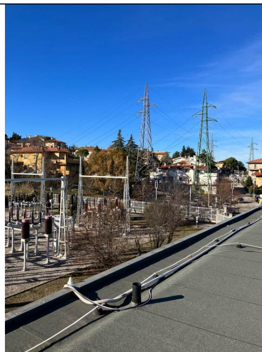
Condutture in copertura
