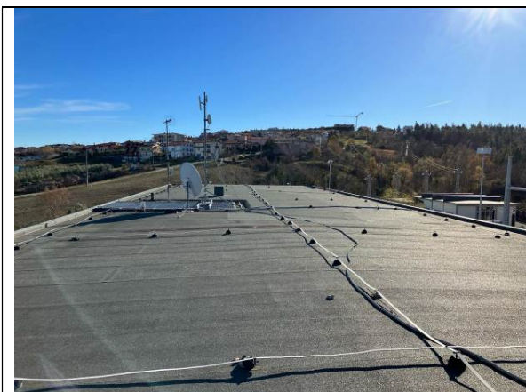
Particolare Calata integrata nella struttura
